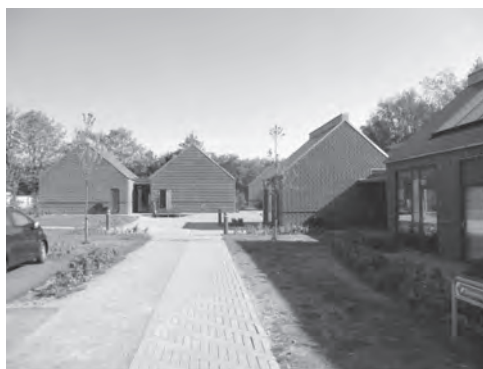
リンネビヤウ 集合住宅
