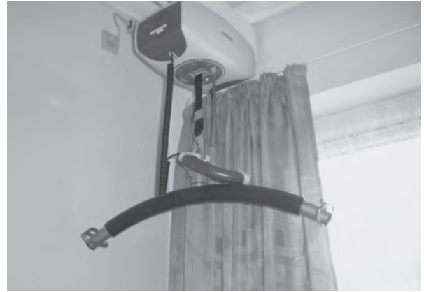
レールに設置してあるリフト
