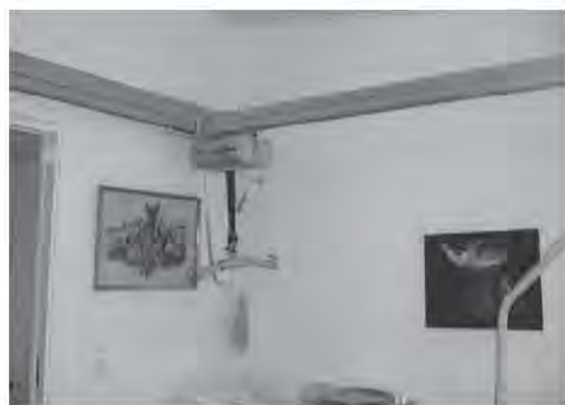
各居室の天井にリフトが設置されている
